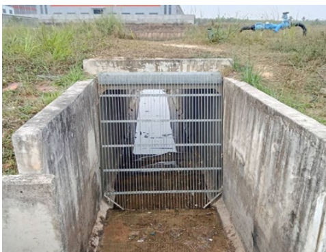
ภาพที่ 2-11 ท่อลอด (Box Culvert) และท่อคอนกรีต
