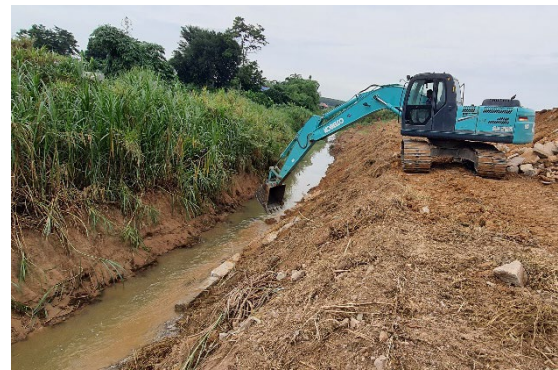
ภาพที่ 2-12 การขุดลอกคลองสาธารณะ ลำรางห้วยพันเสด็จ
